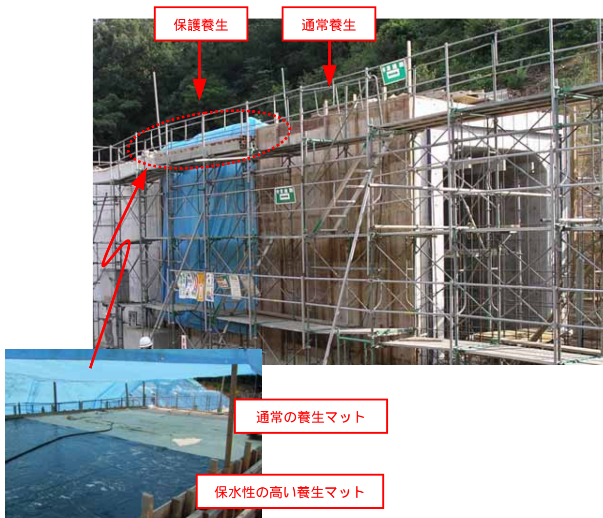
図 3.4.2 養生効果確認実施状況（H18 試行施工）
